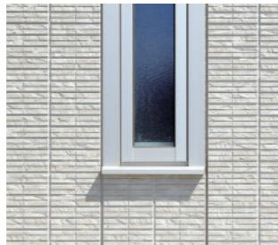
セメント質と繊維質を主な原料として板状に形成した素材。施工が容易でコストが安いため、新築時の最もポピュラーな吹きつけ仕上げ材として使用されている。基材は吸水性があり、防水機能は塗膜に頼っているため、塗膜の劣化を放置すると建物の構造に大きなダメージを与える可能性もある。
