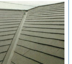
代表的な屋根のひとつで、石質の薄い板を使用。劣化すると表面の割れや反り、屋根面の接合部の下地の腐食、板金を止めている釘の浮きが起こり始める。10年以上経つと汚れやコケが付いたり、色あせも目立つようになるので、内部に腐食がないか点検してもらおう。
