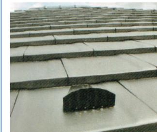
寿命が長く、色落ちがほとんどない粘土瓦。汚れがひどい場合は洗うか、部分的に交換するかを検討する。ズレや浮きがあれば、瓦を固定している屋根面の接合部の漆喰が崩れている可能性あり。コケや雑草を放置すると根から雨水を屋根に引き込む原因になる。
