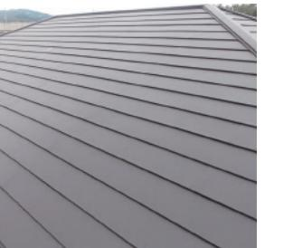
ガルバリウム鋼板は、アルミニウム55%、亜鉛43.4%、シリコン1.6%から成る、アルミ亜鉛合金めっき鋼板。アルミニウムの特徴である耐食性、加工性、耐熱性、熱反射性と、亜鉛の特徴である犠牲防食機能により、従来の鋼板よりも、さらに耐久性に優れ、あらゆる用途に対応できる画期的な鋼板。
