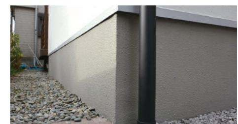
基礎も塗ることで、雨水や湿気からのコンクリートの中性化を抑制。住宅の土台である基礎コンクリートを長期に渡って保護します。
