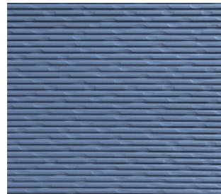
スチールやアルミニウムなどの金属鋼板のこと。デザイン性・耐久性に優れた表面材（金属板）と断熱性・防火性に優れた裏打材によって形成され、軽くて耐久性に優れる。美観維持、防カビのために10～15年で要再塗装。塗膜を傷めてしまった場合はすぐに処置が必要。
