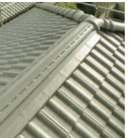
セメント瓦とは、セメントと川砂を1対2～3の割合で混ぜたモルタルを、型に入れて形成し塗装したもの。紫外線・風雨・温度変化などで塗膜の劣化が進行すると、素材のセメントの劣化も早くなるので、もろくなる前に定期的なメンテナンスをおすすめする。
