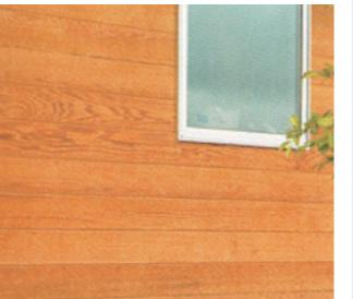
木材は乾燥収縮等が起こり、割れが生じる可能性があるため、厚みのある材料を使用することが大切。板の重ね部分が不十分だとつなぎ目から雨水が入り込むこともあり、外壁の変化を注視しながら、しっかりとメンテナンスが必要になる。
